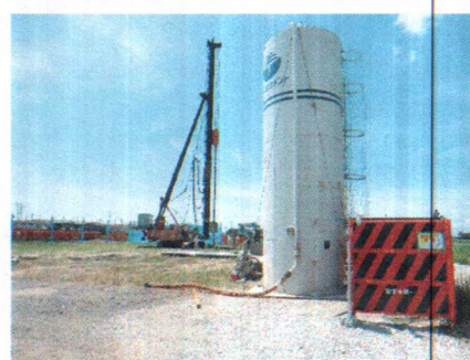
H24-08-27 「悠紀の里」基礎工事
