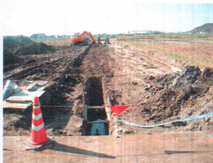
H23-12-04 建設取付け道路造成
