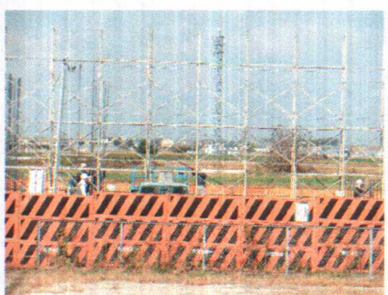
H24-11-07 「悠紀の里」建設工事
