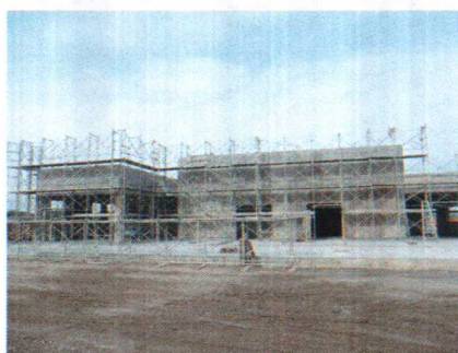
H25-01-15 「悠紀の里」建設工事
