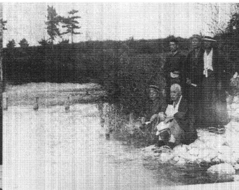
高橋用水取入れ(明治15年着工)
